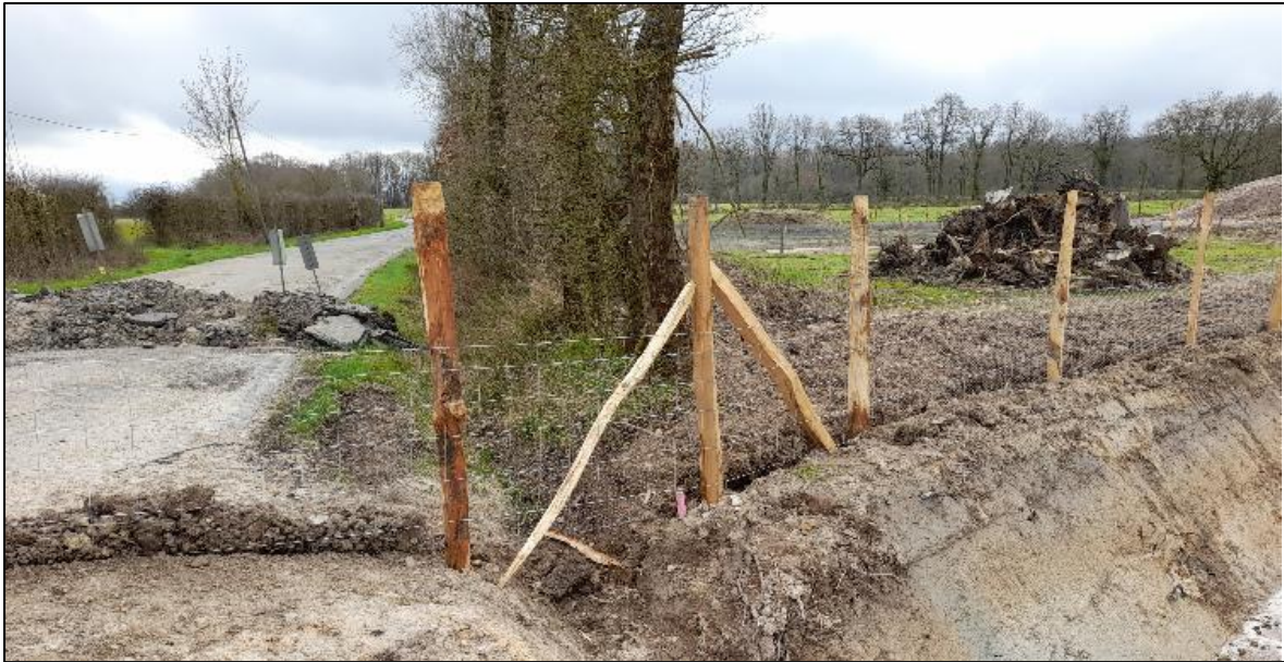
Figure 42: illustration de mise en défens en phase chantier
