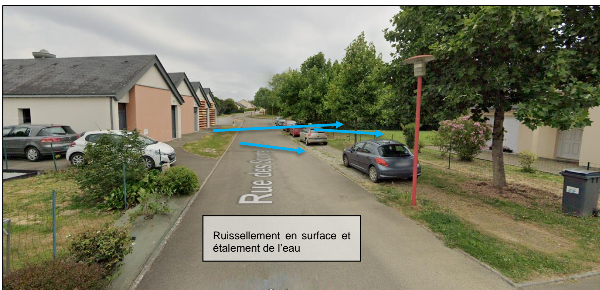
Photo 48: ruissellement en aval de l'école et à l'exutoire du réseau enterré (source Google street annoté)
